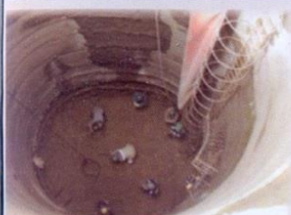
POZO DE COMPUERTAS (57.8 m. quedando pendiente 7 m.)
