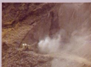
ESTRIBO DERECHO (Evacuación en roca por voladora y con equipo en el camino de acceso a galería)
