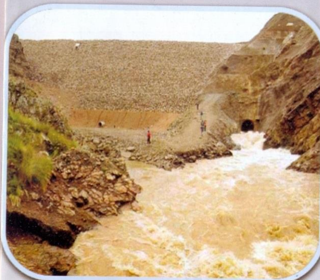
Túnel de desvío - aguas abajo
